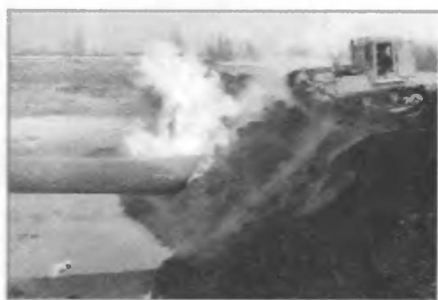
Авария на химически опасном объекте. Мощный взрыв повредил участок газопровода «Пермь — Горький». Ремонтно-восстановительные работы на месте взрыва. 10 декабря 2002 г.
