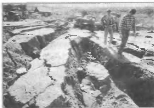
Разломы земной коры в результате землетрясения на Курилах. Остров Итуруп. Октябрь 1994 г.
