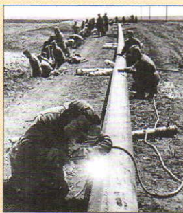
Строительство газопровода Саратов — Москва
