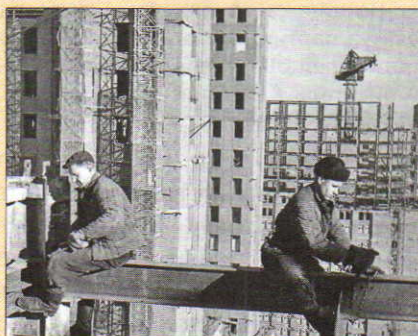
Строительство комплекса зданий МГУ на Ленинских (Воробьёвых) горах
