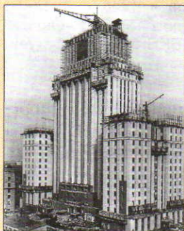
Строительство высотного здания на Смоленской площади
