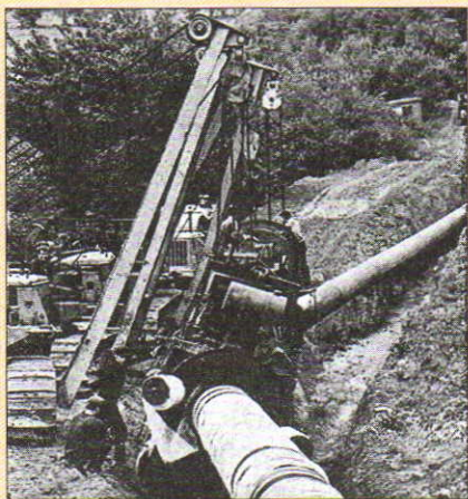
Строительство нефтепровода «Дружба»
