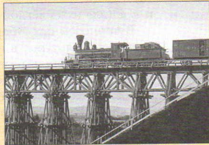
Строительство железной дороги в Сибири. Фото второй половины XIX в.
