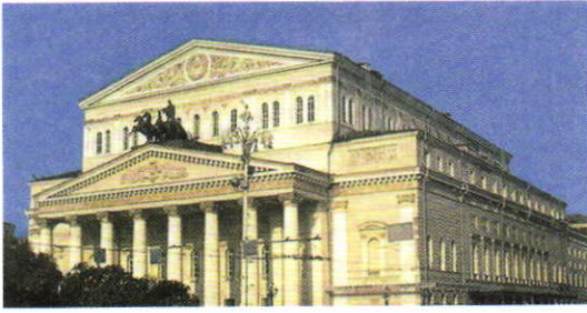
Москва. О. Бове, А. Михайлов. Большой театр на Театральной площади. 1821—1853. Восстановлен после пожара в 1853 г. под руководством архитектора А. К. Кавоса.
